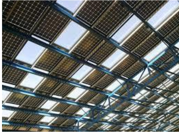
«شکل ۱»: یک نمونه از BIPV در آرایه‌های فتوولتاییک که با سقف ترکیب می‌شوند.
