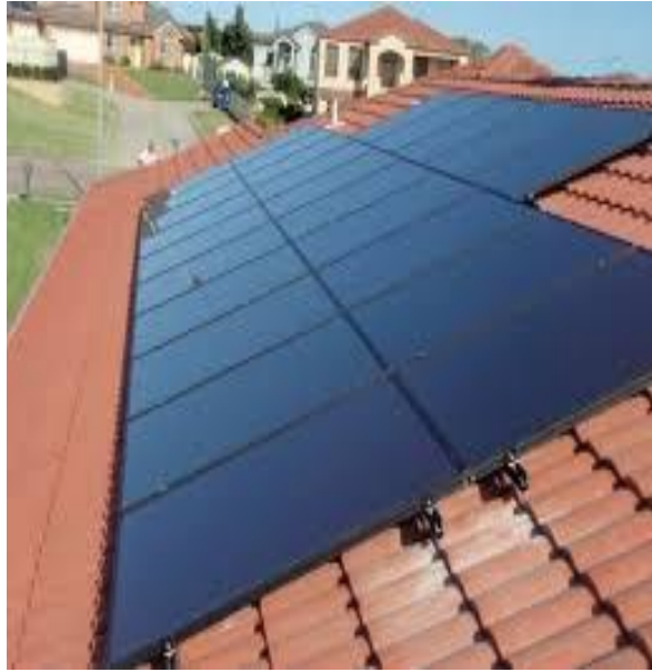
«شکل ۲»: یک نمونه از BAPV با آرایه‌های فتوولتاییک متصل به پشت‌بام
