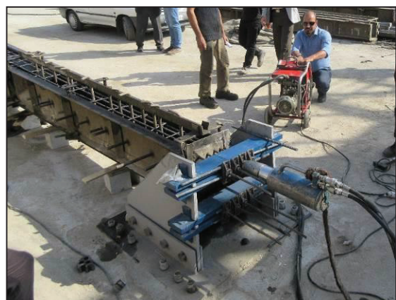
شکل ۱۷: عملیات کشش کابل‌های (استرند) هفت رشته‌ای
