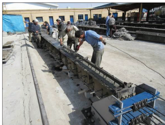
شکل ۱۸: کنترل جانمایی خاموت‌ها (بالا) و بتن ریزی پایه پیش تنیده (پایین)
