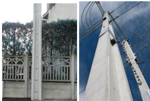
شکل ۱۰: پایه بتنی پیش تنیده چهارگوش شبکه توزیع نیوزلند و فرانسه [۲]
