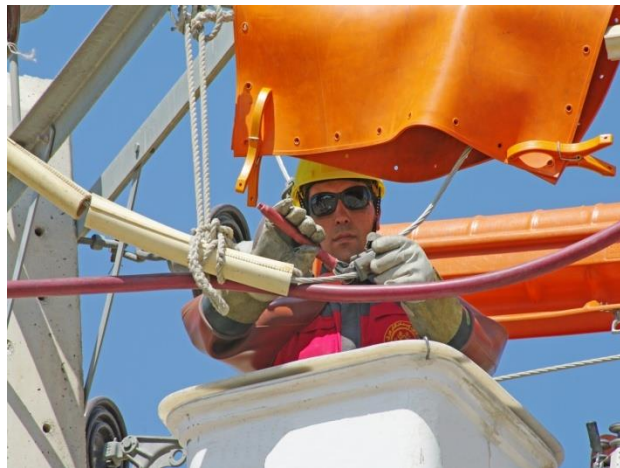
عکس ۱۱ - نصب ژامپر موقت و باز کردن بست شبکه با خط گرم
