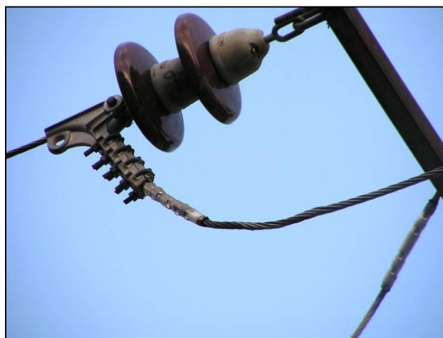
عکس ۵ - نمونه ای از ژامپر بوش زده شده
