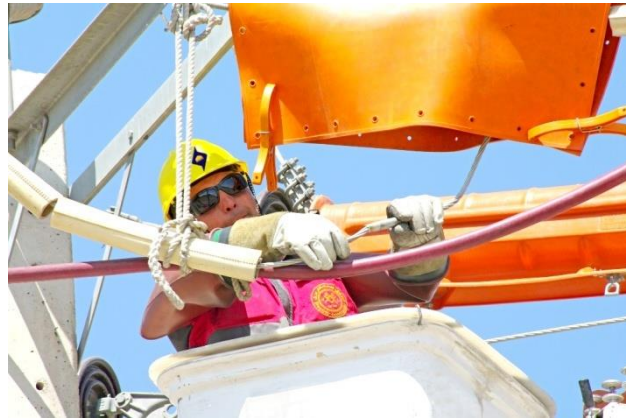
عکس ۱۲- نصب پوش بجای بست با خط گرم
