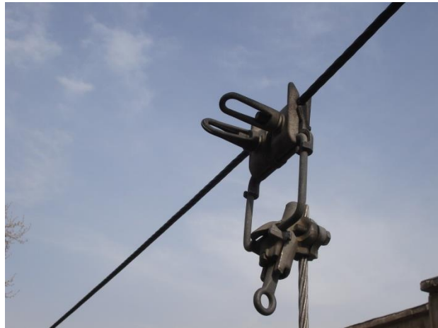
عکس ۷ - استفاده از رکاب و قفل هات لاین جهت انشعاب گیری
